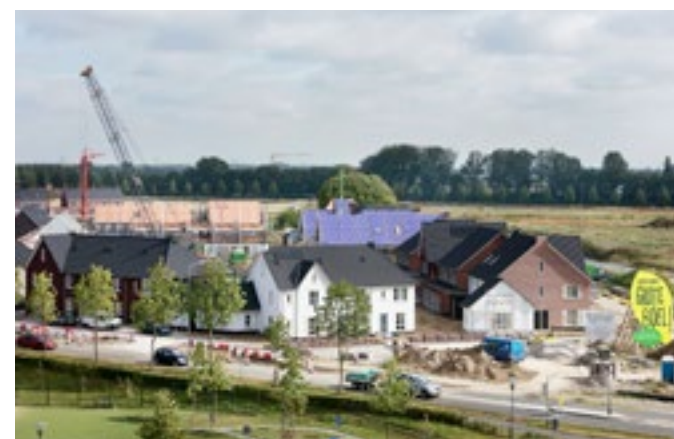
Verschillende bouwbedrijven zijn hard aan het werk in Grote Boel.
