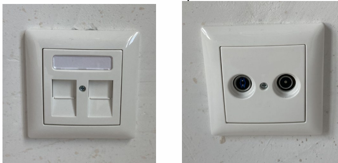
In de woonkamer zit een bedraad data-punt en een bedraad tv-aansluiting
