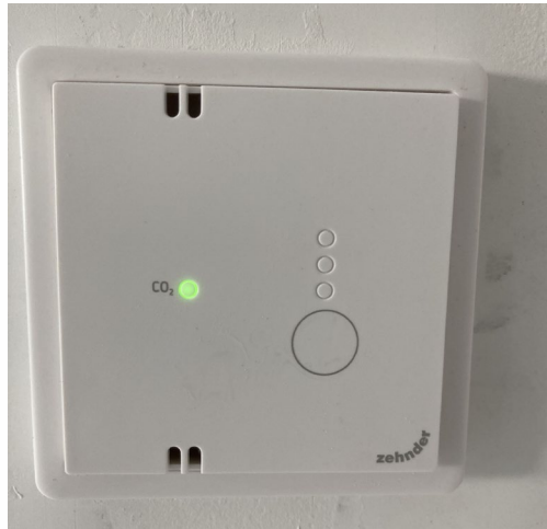
In de woonkamer en slaapkamer hangt de bediening van de mechanische ventilatie
