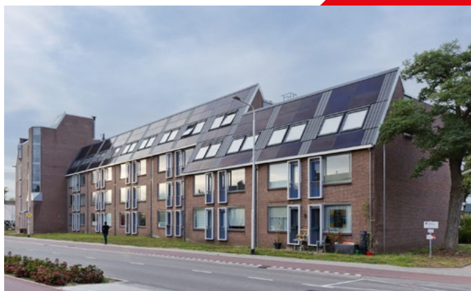
Op het hele dak zijn zonnepanelen aangebracht.
