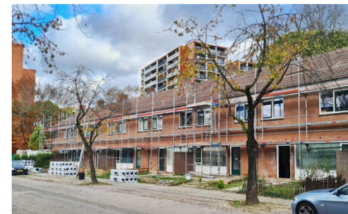
Het groot onderhoud in Dukenburg is begonnen.
