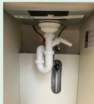
In het kastje onder de gootsteen zit een leiding voor een vaatwasser.
