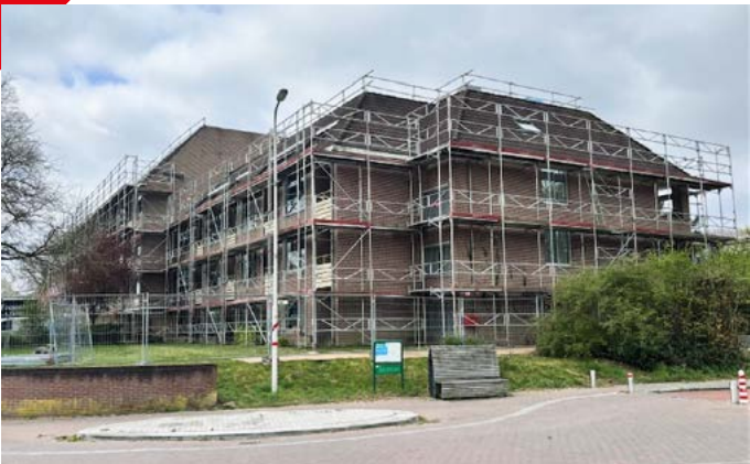
Het woongebouw wordt helemaal opgeknapt.
